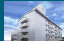
Maison des Centenaire Ishizugawa
